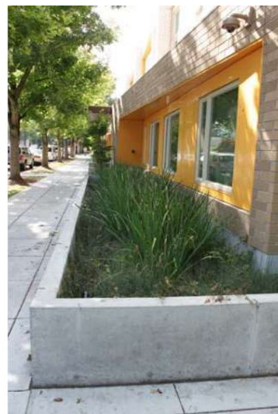
Figur 10. Växtbäddar intill husvägg som samlar upp takvatten (foto av WRS från (Stockholm Vatten och Avfall, 2017a))
